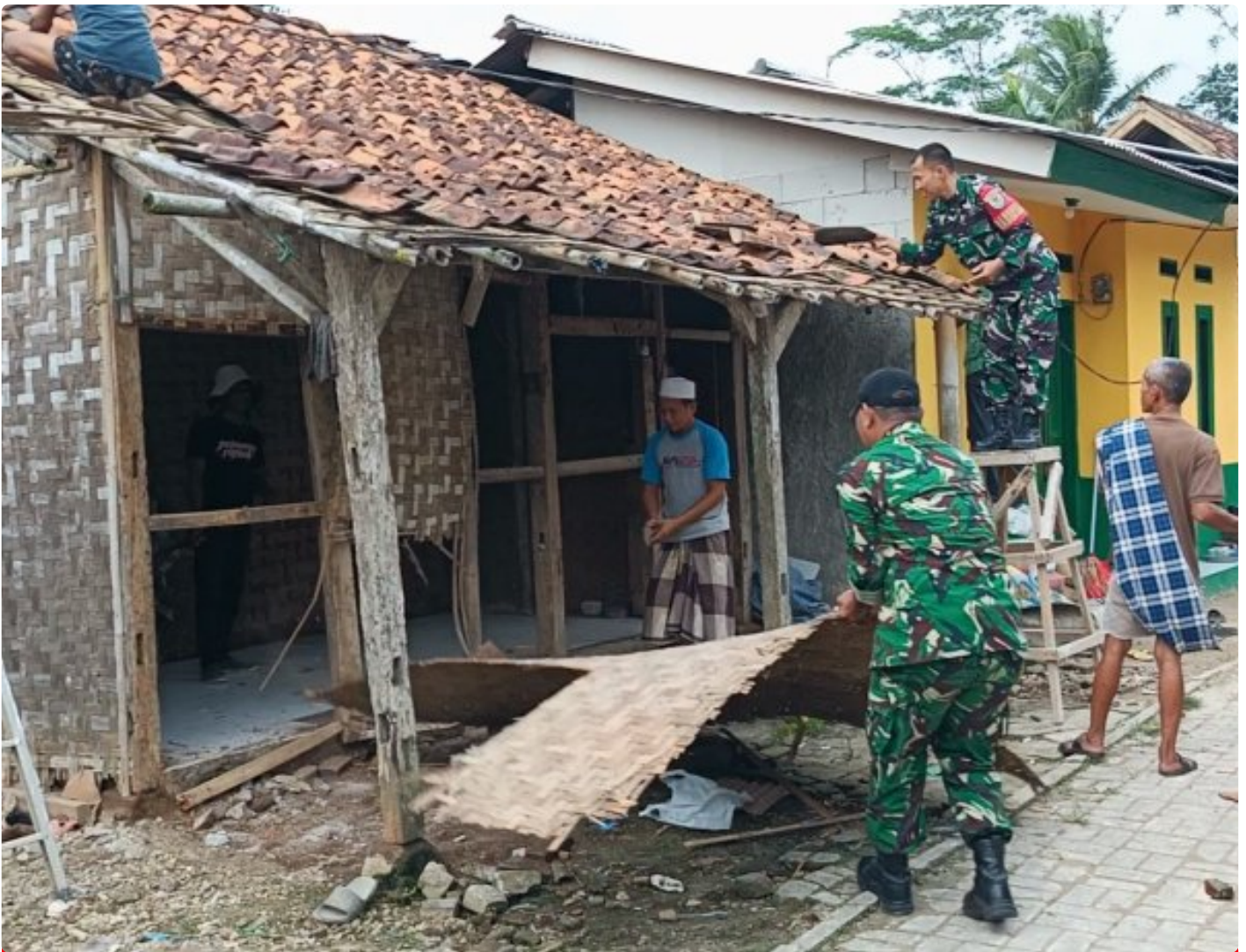
Pembongkaran Rumah Bapak Narmin
